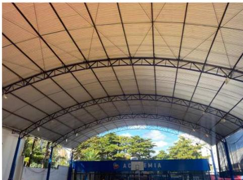
A utilização de triângulos na construção é uma aplicação inteligente das propriedades geométricas para criar estruturas fortes, estáveis e eficientes. A rigidez inerente dos triângulos continua a ser uma das razões pelas quais é um elemento fundamental em projetos de engenharia e arquitetura.
